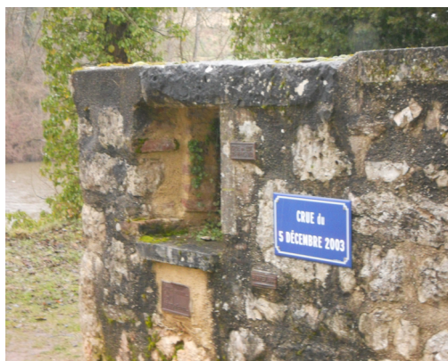
Exemple de repère de crues
