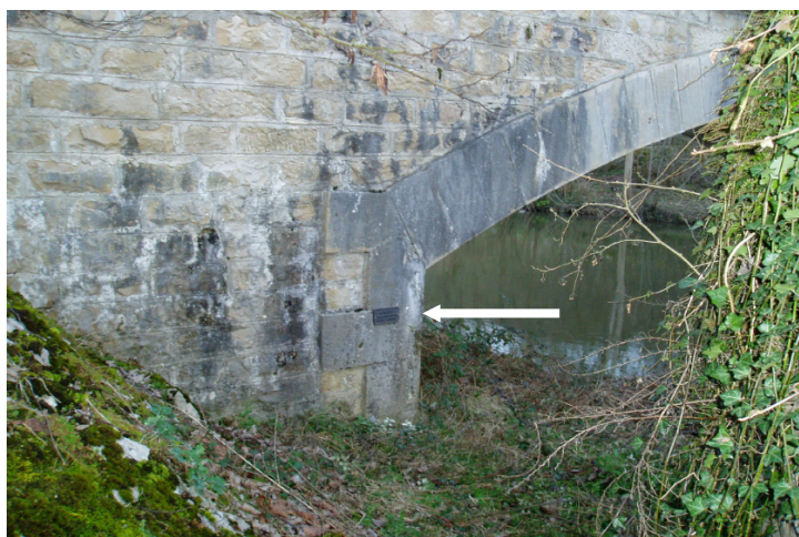
Pont RD n°48 Culée rive droite Cote NGF69 au 04/12/2003: 176.68m
